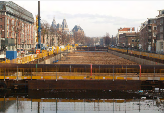
Parkeergarage in aanbouw
