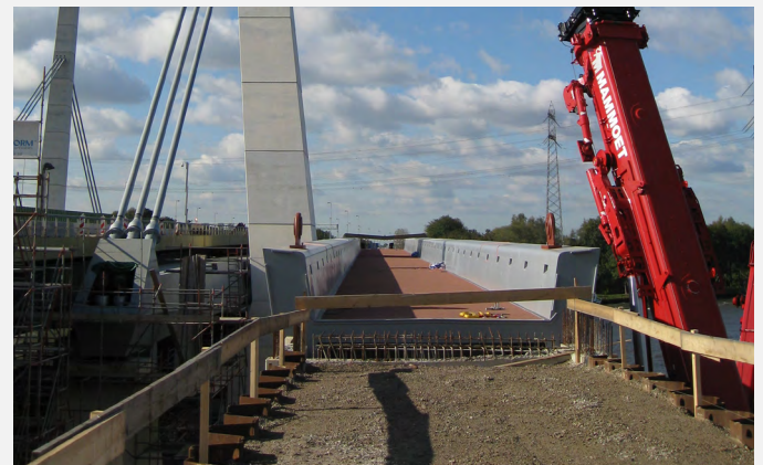
Muiderfietsbrug under construction, 2009
