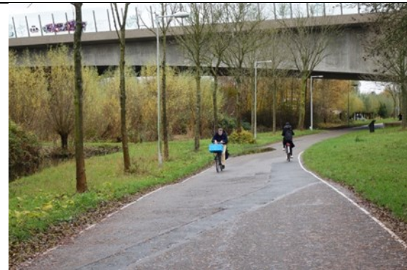
5cm brede kantmarkering maakt het wegverloop langs Amsterdam-Rijnkanaal duidelijk, tenzij deze met blad is bedekt.
